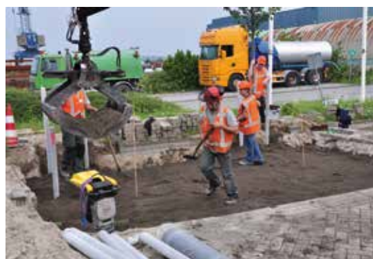
Application en couches de 30 cm du substrat constitué de matériaux recyclés et compactage de chaque couche à l'aide d'une pilonneuse.
