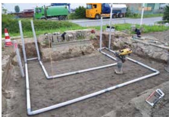
Excavation réalisée et système d'aération en place.
