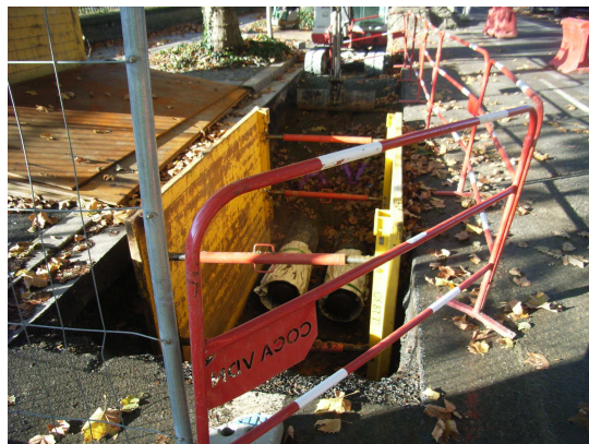
Réalisation d'une tranchée
